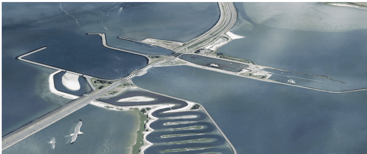
De vismigratierivier naast het sluizencomplex van Kornwerderzand, foto RWS
