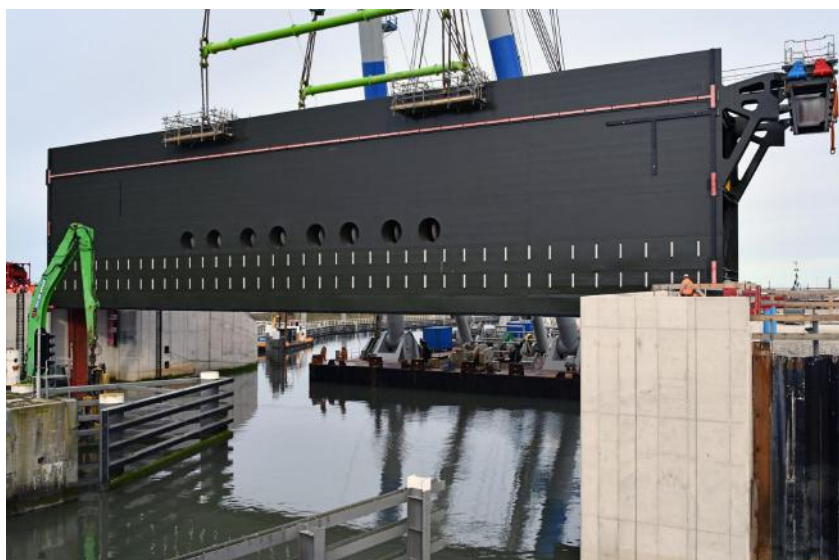
De roldeur wordt in de keersluis bij Kornwerd geplaatst, foto RWS
